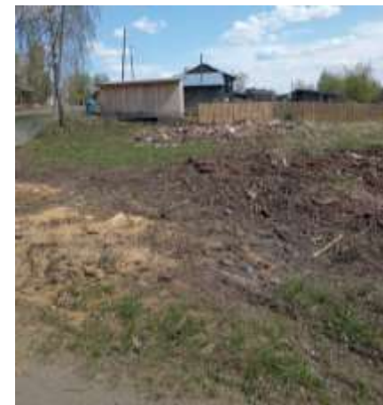
Зачистка территории от отходов пилорамы (Орджоникидзевский сельсовет)
